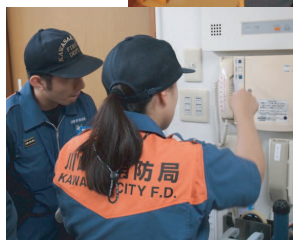
火災報知機を点検する隊員
